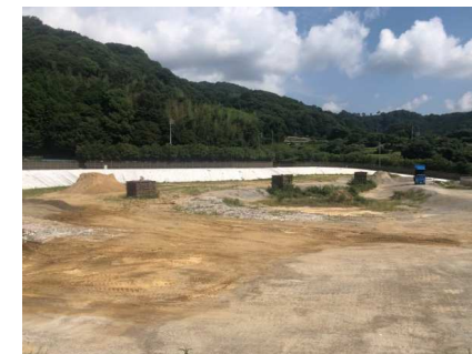
ごみ最終処分場
