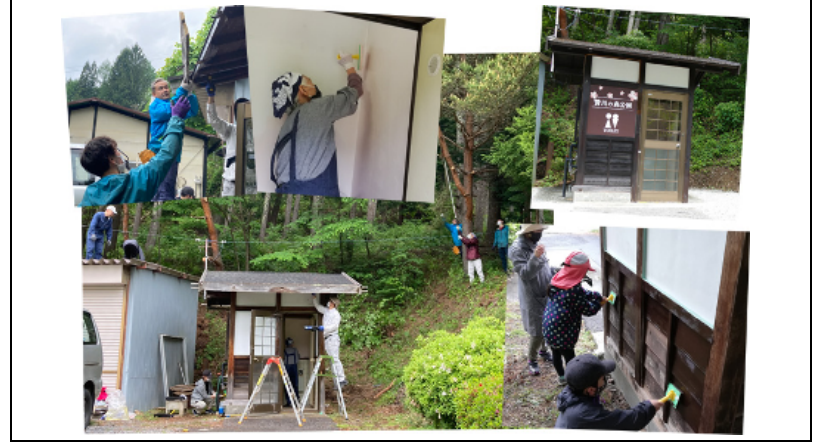
作業風景（公衆トイレの改修）
