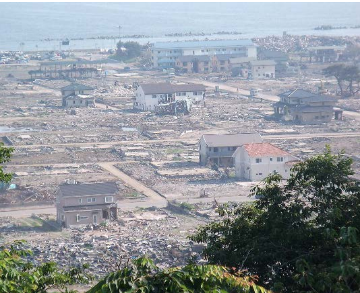
▼ 東日本大震災の被災状況
