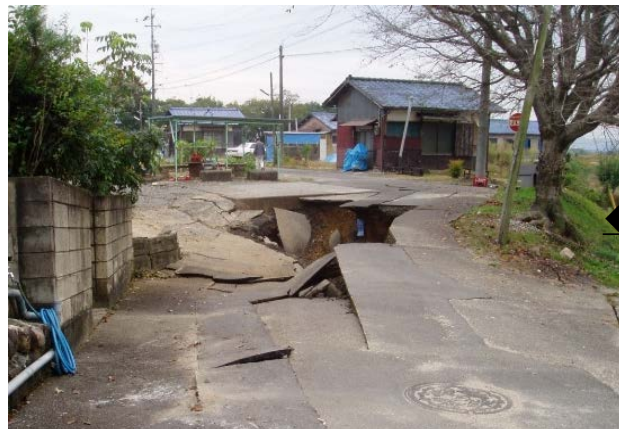
▼ 御嵩町の亜炭鉱陥没被害状況
