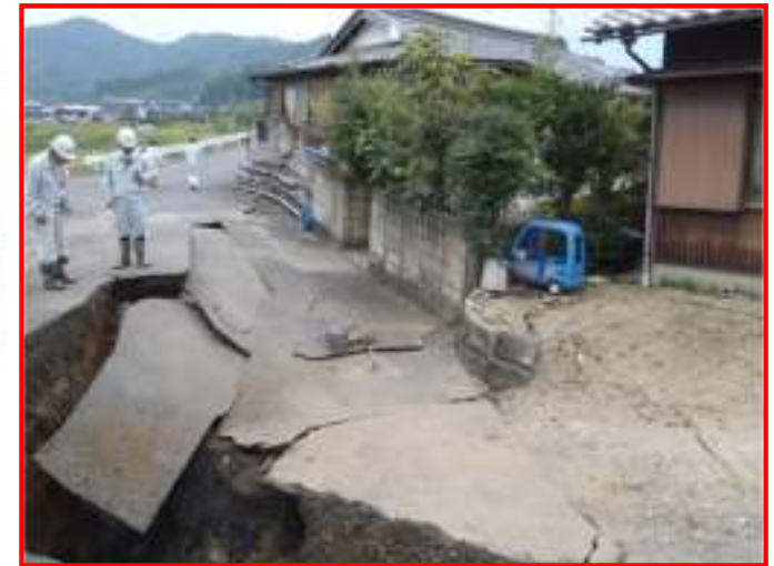
(写真:平成22年10月に発生した大規模陥没被害)
