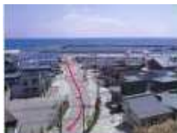
漁港から高台への避難路の整備
