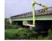
橋梁点検車を使った橋梁点検
