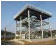
避難施設の整備
