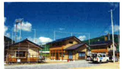
気仙環境共生型木造復興モデル住宅の建設
