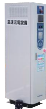
市内5ヶ所の公共施設駐車場にEV用急速充電器を設置。
