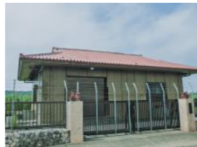
地下ダムから水を汲み上げるポンプ小屋が島内のあちこちに設置されている。ここからファームポンドと呼ばれるタンクに水を汲み上げ、畑にスプリンクラー施設などを通して散水している。
