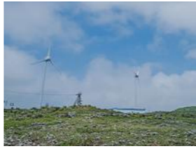
宮古島の風力発電の歴史は古く、1992年に1号基が稼働。現在は2003年の台風での倒壊事故の教訓を生かしブレードに改良を加えた風力発電施設が5基建っている。
