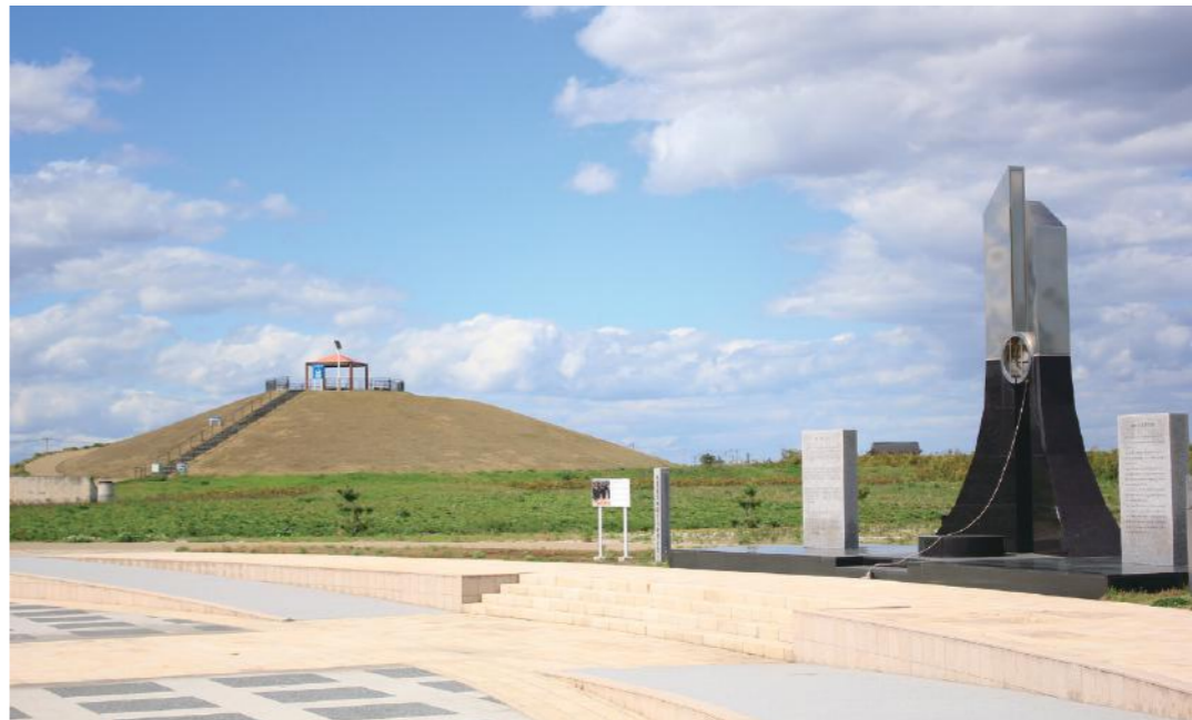
上／慰霊碑及び再生資材を使い築造された避難丘。震災では高さ約11メートルの丘が市民の命を守ったという事例があった。2号丘の上にはソーラーパネルもあり、避難時の電源供給を可能としている。 左／1号丘のモニュメントに埋め込まれているガラスボールは、震災で壊滅的な被害を受けた6集落の位置を表す。 右／植物生態学者の宮脇昭さん指導の下、ボランティアが参加し行った植樹祭。
