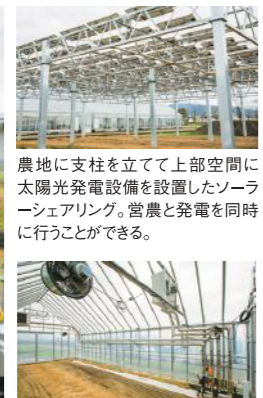
農地に支柱を立てて上部空間に太陽光発電設備を設置したソーラシェアリング。営農と発電を同時に行うことができる。
