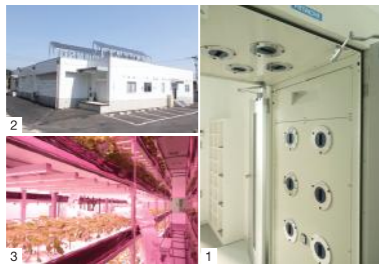
1.工場内では栄養素、温度などすべてが管理され農業は一切使わない。エアシャワーも完備。 2.3.ヒートポンプ、太陽光発電なども活用される。
