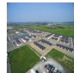
スマート防災エコタウン(赤井地区)
