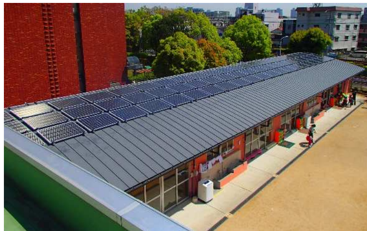
1 階屋根 66 枚のパネルを設置
