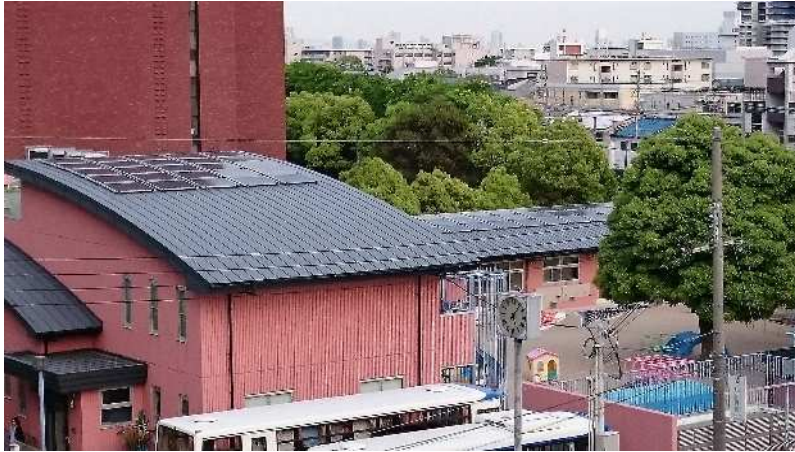
1 階屋根 66 枚のパネルを設置
