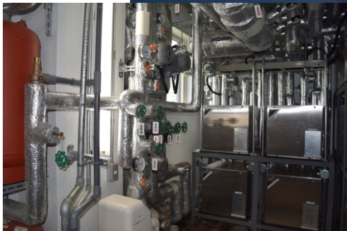
ニセコ町民センター(2011年大規模改修) ・断熱性能の向上(外断熱・高断熱樹脂サッシ) ・電気はLED電球。 ・屋根には軌道追尾式太陽光発電。 ・地中熱ヒートポンプによる冷暖房(冷房は大ホールのみ) 暖房 10kw×19台(冷房6台)、 ポアホール 80m×31本
