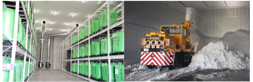
JAようてい雪氷熱米倉庫(2013年新築) ・貯蔵庫 玄米940t×2室 ・貯雪庫 雪1,300t
