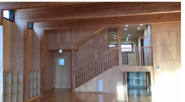
学童保育施設(ニセコこども館)(2015年新築) ・構造材に町内から伐採したカラマツ使用。 ・木質繊維断熱材。木製サッシ使用。 ・地中熱ヒートポンプによる暖房 暖房 10kw×2台、ポアホール 100m×3本
