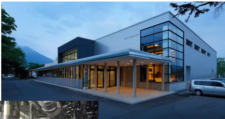
JAようてい雪氷熱米倉庫(2013年新築) ・貯蔵庫 玄米940t×2室 ・貯雪庫 雪1,300t
