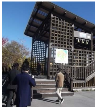
電力事業者と飯田市が共同で建設した太陽光発電所「メガソーラーいいだ」の見学施設
