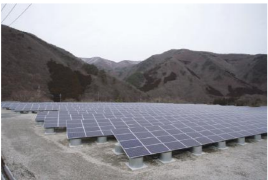
下)約3000人が暮らしていた釜山勤務者の社宅。昭和30年代の写真 右)社宅跡地に敷き詰められたソーラーパネル。年間発電量は約220万キロワットアワーで、一般家庭約500世帯分に相当する
