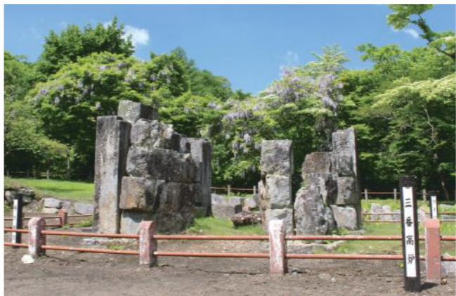
橋野高炉跡の三番高炉。花こう岩の基壇2段の上に約5.4メートル四方、高さ2.8メートルの石組み（5段）が積み、四隅に縦長の花こう岩が配置されている
