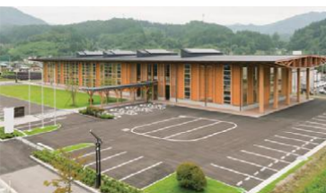
住田町役場新庁舎 2014年9月に完成した住田町新庁舎。住田町のスギ材やカラマツ材を使用した。木質ペレットボイラーを用いた冷暖房システムや太陽光発電設備を導入し、環境に優しく、災害にも強い造り。
