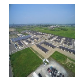
スマート防災エコタウン(赤井地区)
