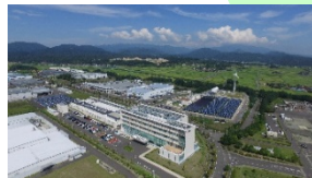
産総研 福島再生可能エネルギー研究所
