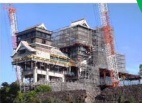
復旧中の熊本城
